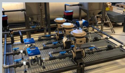
Praktijkgedeelte in de Duurzaamheidsfabriek in Dordrecht.
