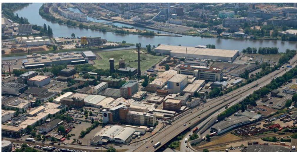
Das SAMSON Werksgelände in Frankfurt am Main Foto: SAMSON AG
